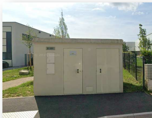
Poste de transformation de type UP à Gueux (Source Google maps)
