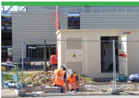
Chantier Axon'Cable à Montmirail
