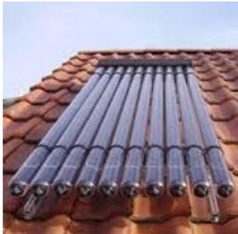
Les **panneaux solaires thermiques** piègent la chaleur du rayonnement solaire lequel chauffe un fluide caloporteur. Ce fluide restitue la chaleur dans le ballon d'eau chaude ce qui
