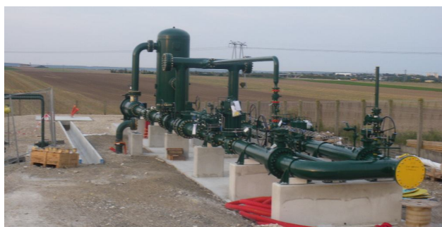
Poste de livraison de CERNAY LES REIMS
